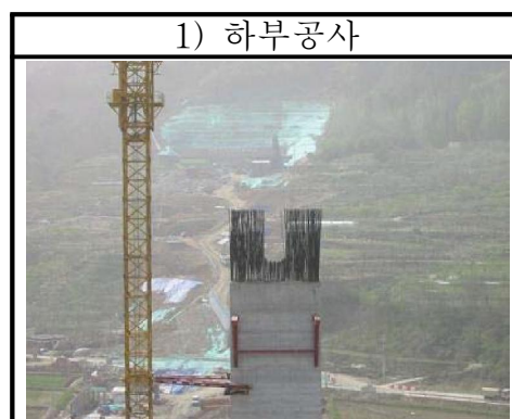
<그림 3> F.C.M공법의 시공순서
