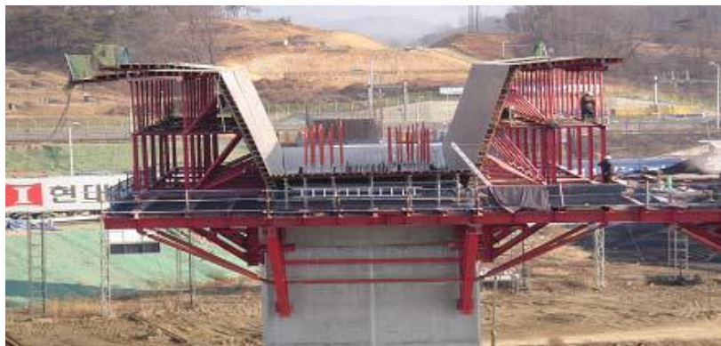
<그림 9> 주두부 브라켓에 설치된 거푸집
