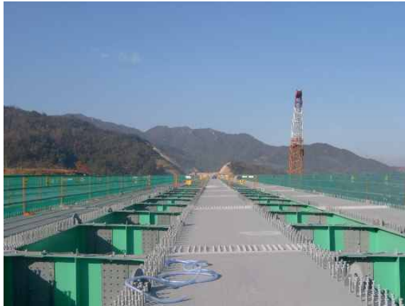
<그림 11> 강거더에 설치된 안전난간
