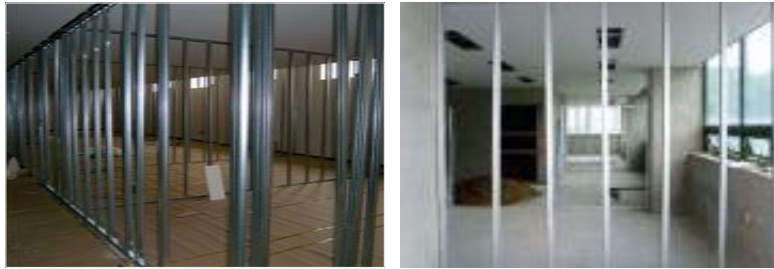
&lt;그림 15&gt; 상하부 런너(Runner) 및 스테드(Stud) 설치
