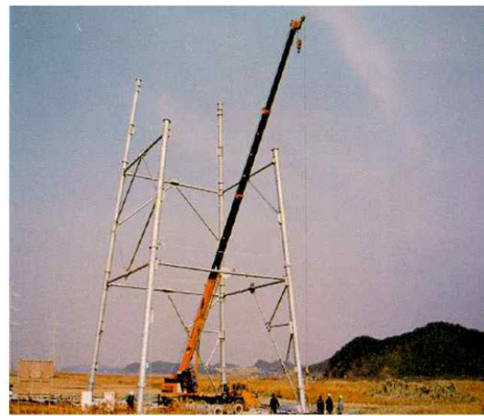
&lt;그림 5&gt; 이동식 크레인 공법
