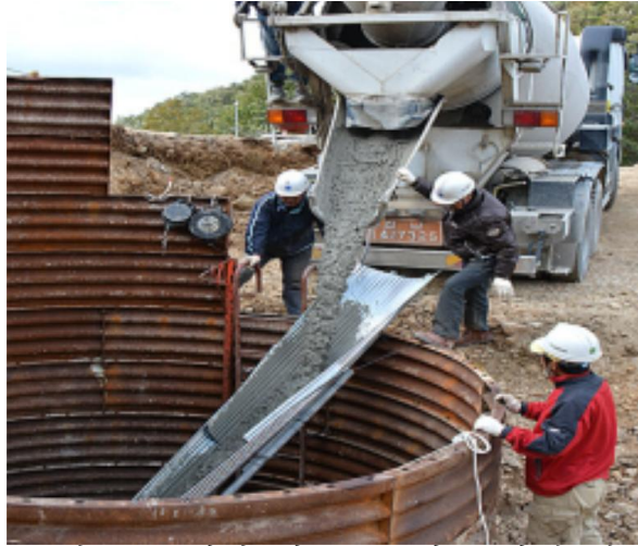
<그림 18> 철탑 기초콘크리트 타설 전경
