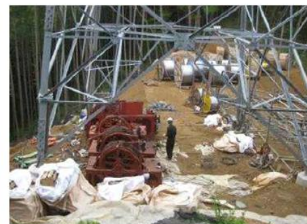
<그림 31> 풀러텐서너(Puller Tensioners) 연선작업 및 전력선 요크 부착
