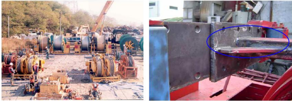
<그림 29> 연선차 설치전경 및 고정프레임 실제부착모습
