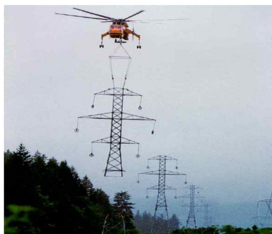
&lt;그림 7&gt; 헬기 조립 공법
