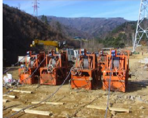
<그림 26> 드럼장 용지조성 및 연선차 앵커, 고정와이어 설치
