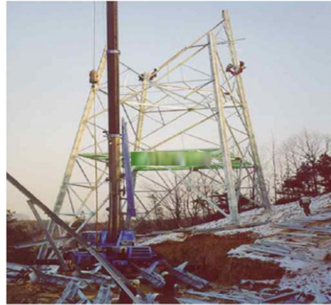
<그림 20> 철탑 하부 안전방망 설치
